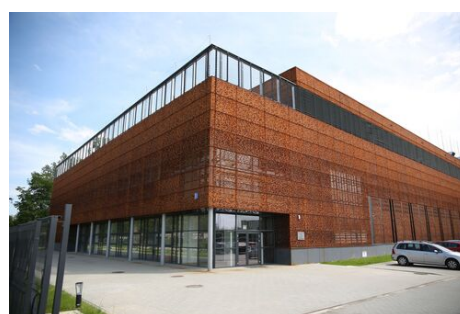
Budynek Serwerowni OCEAN UW
